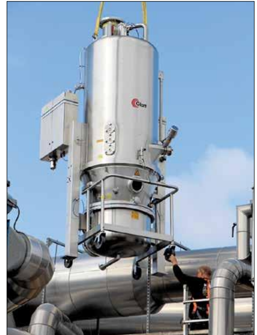
Lige ved og næsten. To forsøg måtte der til, før det lykkedes at få den tyske kæmpe ned gennem hullet i taget. Foto: Solveig
