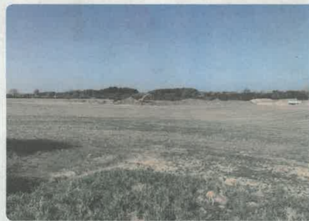
Det første byggeri i Korsør Erhvervscenter er i gang - SK Forsyning er ved at opføre et halmfyret varmeværk.
