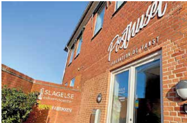
Posthuset på Sdr. Stationsvej i Slagelse har henover efteråret og vinteren gennemgået en større renovering, og nu er det blevet tid til at fejre forvandlingen.
